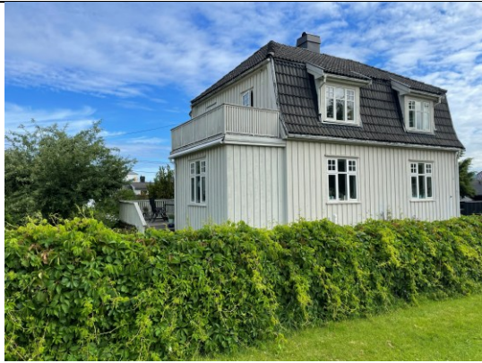
Balkong terrasse i 2.etg
