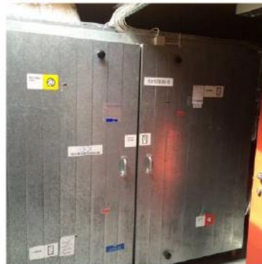
Foto nr. 3-34 ventilasjonsaggregat alder mer enn 20 år teknisk levetid utgått. System 4
