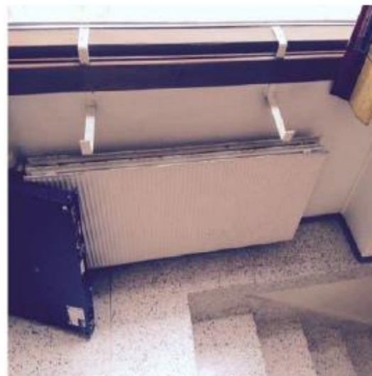
Foto nr. 3-18 viser radiator fra byggeår i gang.
