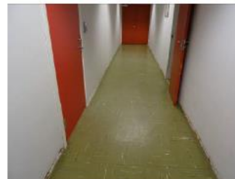
Foto nr. 2- 21 Eldre gulvbelegg
