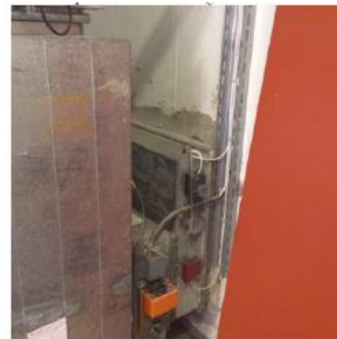
Foto nr. 3-34 ventilasjonsaggregat alder mer enn 20 år teknisk levetid utgått. System 4
