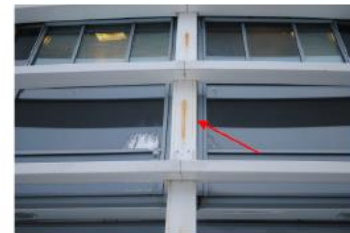
Ruststrenning på stålbjelker.
