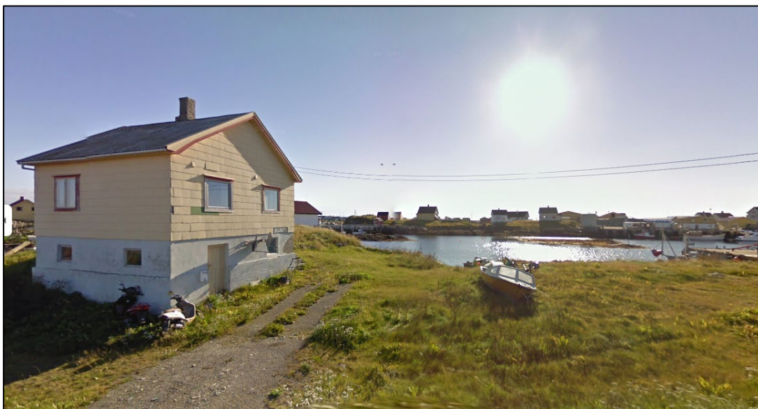
Figur 14: Boligeiendom som foreslås omregulert til næringsformål (Tiltak 3 jfr. figur 11) (Foto: Google)
