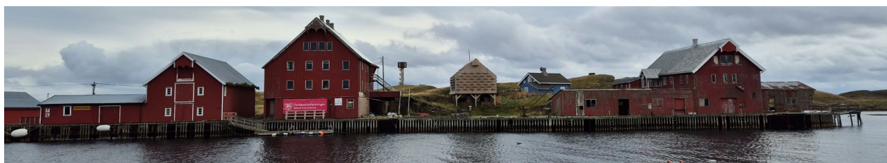
Figur 5-3: Bygningsrekke med diverse hekkende krykkjer, både på tak, på enkelte vegger og særskilt «krykkjehotell» midt i bildet. Bildet er tatt på høsten 2025, utenfor sesong og dermed uten fugl.
