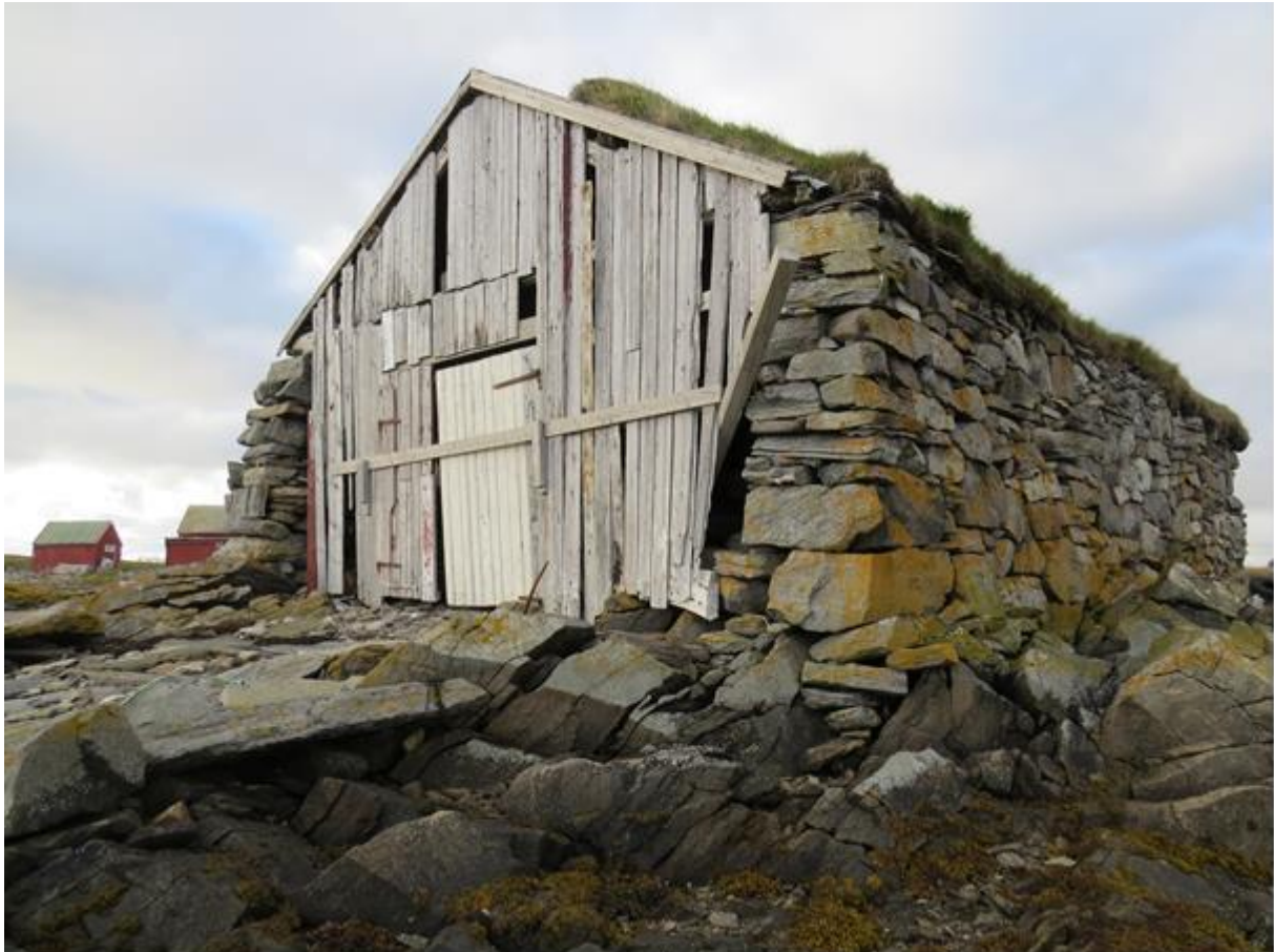
Steinnaustet på Litj-Demma sett fra sør og fra innsiden (under)
