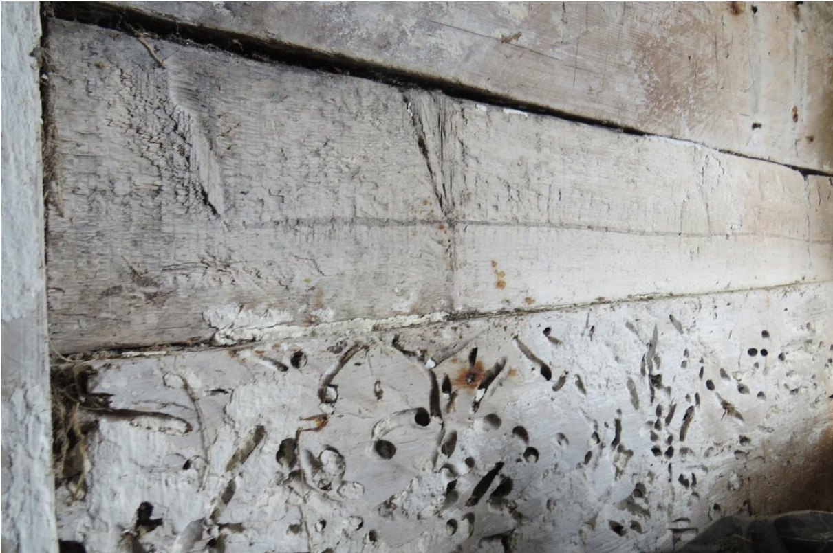
Bruk av drivtømmer i syllstokk. Uthus Gnr. 2 Bnr. 16.
