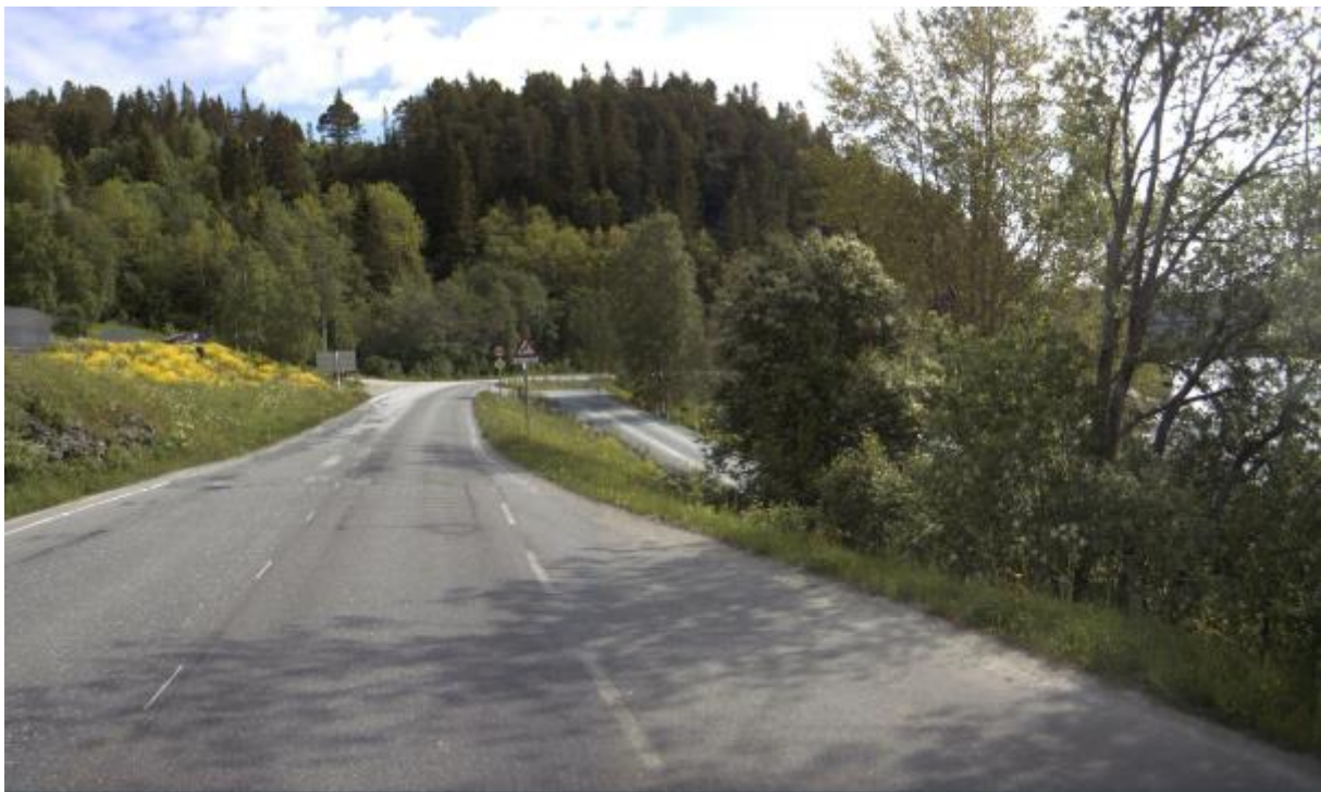
Figur: avkjørsel og privat vei – siktforhold ved kjøring østover (bilde hentet fra https://vegbilder.atlas.vegvesen.no/?lat=63.23276659065222&lng=10.130417801495183&view=image&zoom=15&imageld=Vegbilder_2022.2022-06-08T10.50.19_FV00708_S2D1_m02198_Planar_2&year=2022 )
