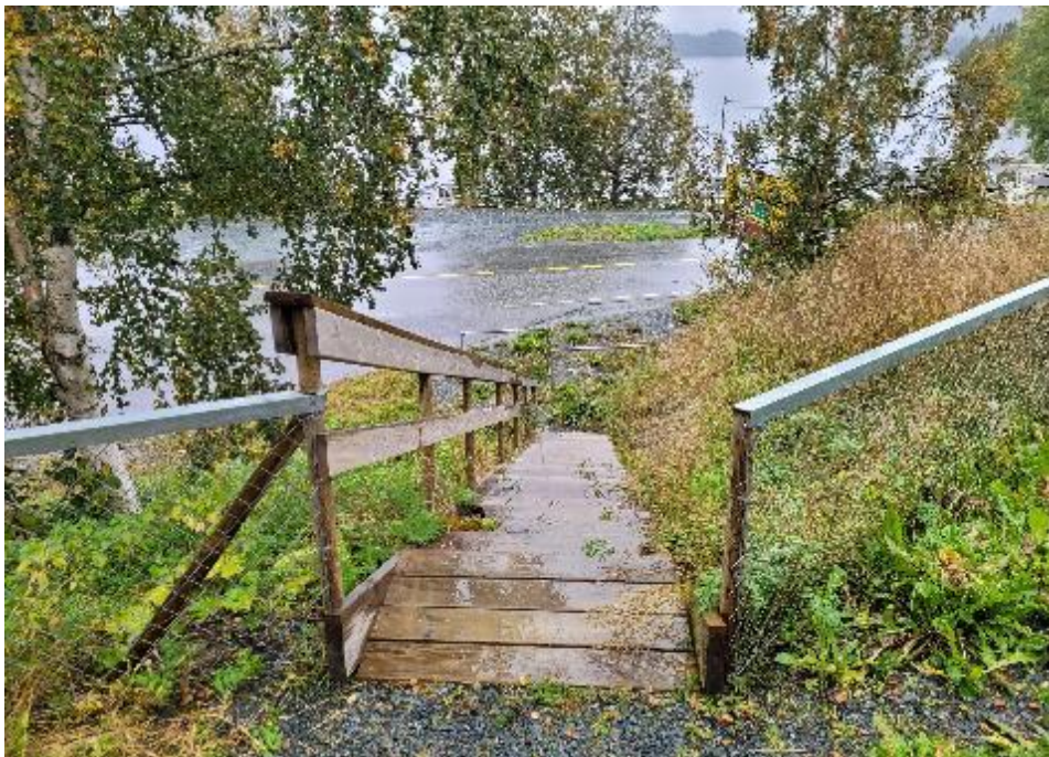
Figur: trafiksikkerhetstiltak – terrengtrapp på oversida av fylkesvegen (bilde tatt ved befaring 23.09.2022, J B Johnsen)
