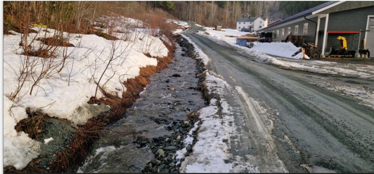
VEDLEGG 16 Bilder fra befaring 7.3.2025. Oppover Hovevegen fra kulvert
