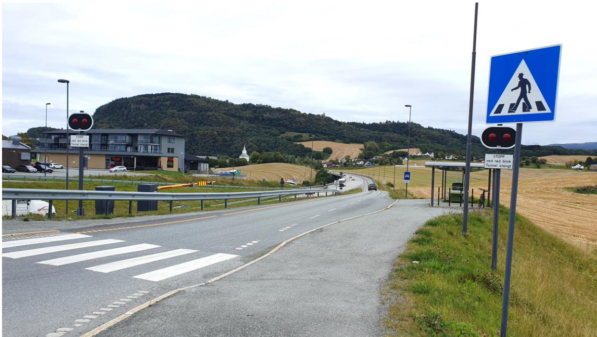
Figur 5-4 Bildet viser Bussholdeplass ved E39, og overgangsfelt til fortau på overgang over E39
