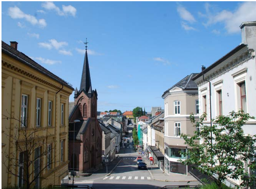
Bygningsskjiljø innanfor tålegrense B, autentiske bygningar og ein helhetlig struktur.
