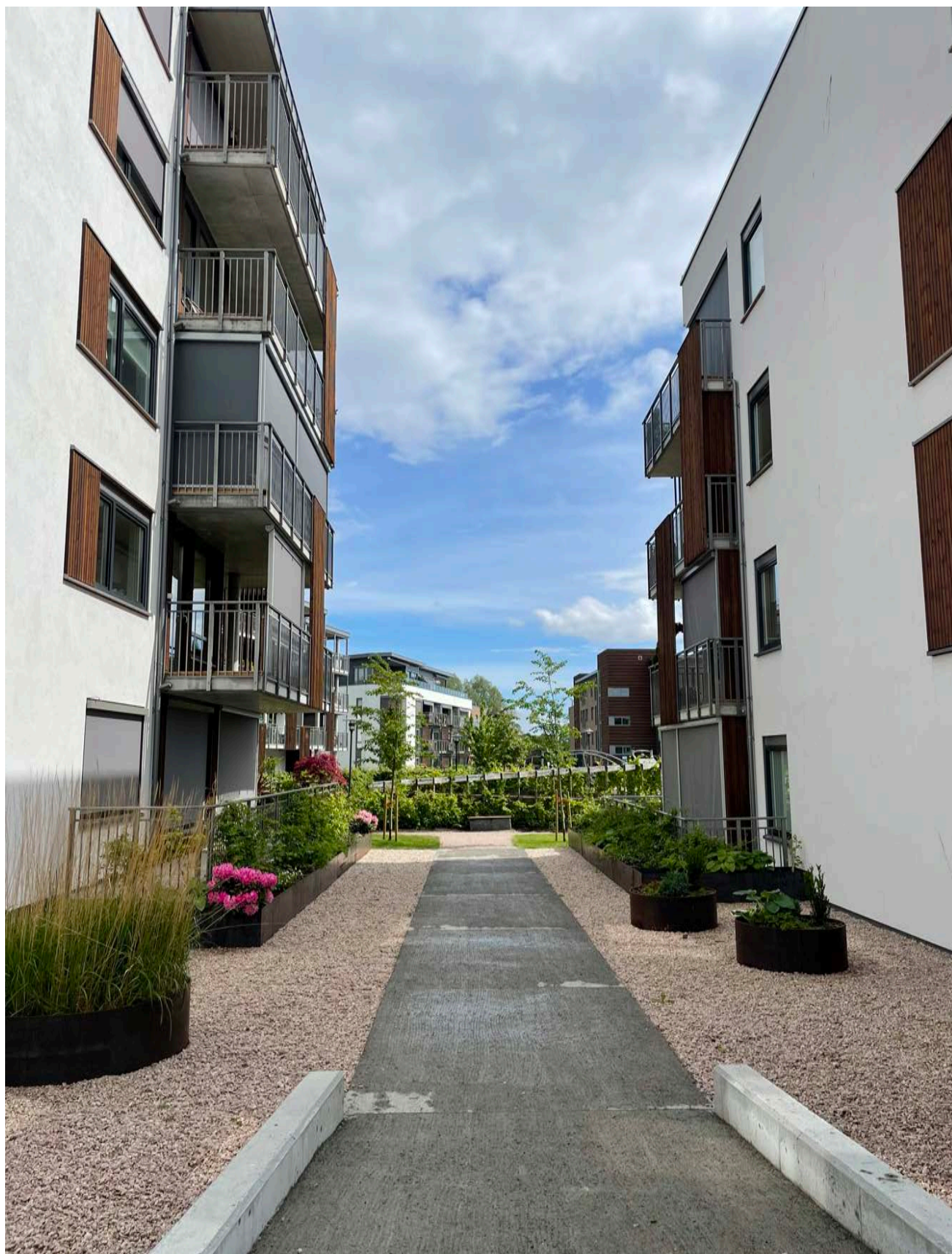
Bygningstiljø innenfor tålegrense D. Fløtningen på Bakken.
