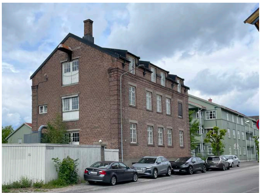
Bygningsskjiljø innanfor tålegrense C, Hauges gate med nye og gamle bygningar.
