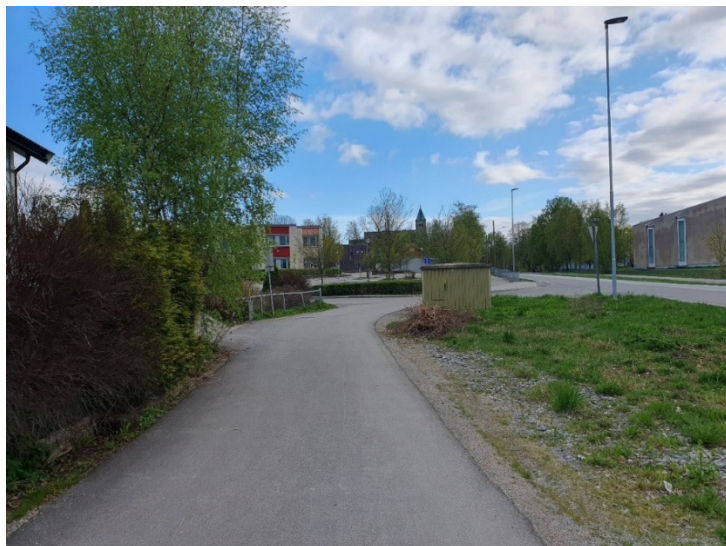
Bilde viser trafokiosken
