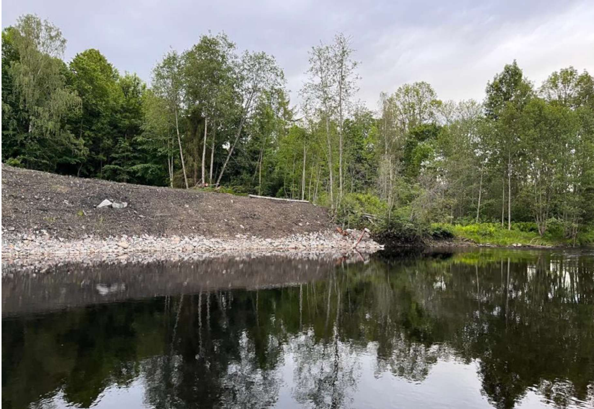
Figur 3-71. Falkumelva ved Fossum. Falkumelva er anadromt vassdrag. Kantvegetasjonen på begge sider av elva er fjernet i forbindelse med erosjonssikring og ny vegbru. Isfugl er observert mange ganger i nettopp dette området. (foto: Odd Magne Darrud).
