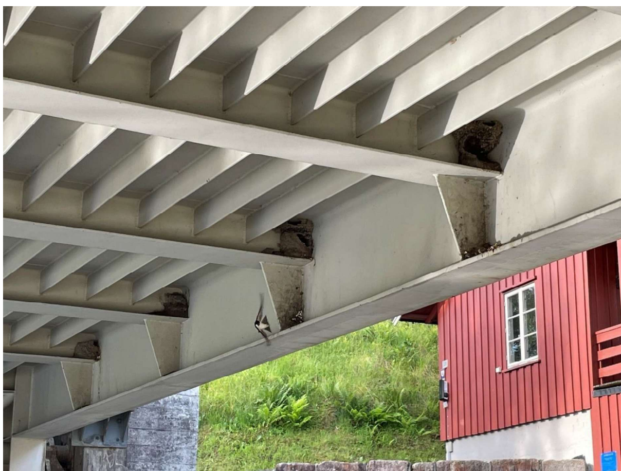
Figur 3-77. Taksvaler (NT) hekker fortsatt flere steder i Skien kommune, her under brua over Løveid sluse. Brua og reirene løftes opp flere ganger daglig. Reirene her blir bygd slik at egg/ungfugler ikke faller ut (foto: H. Liebel).
