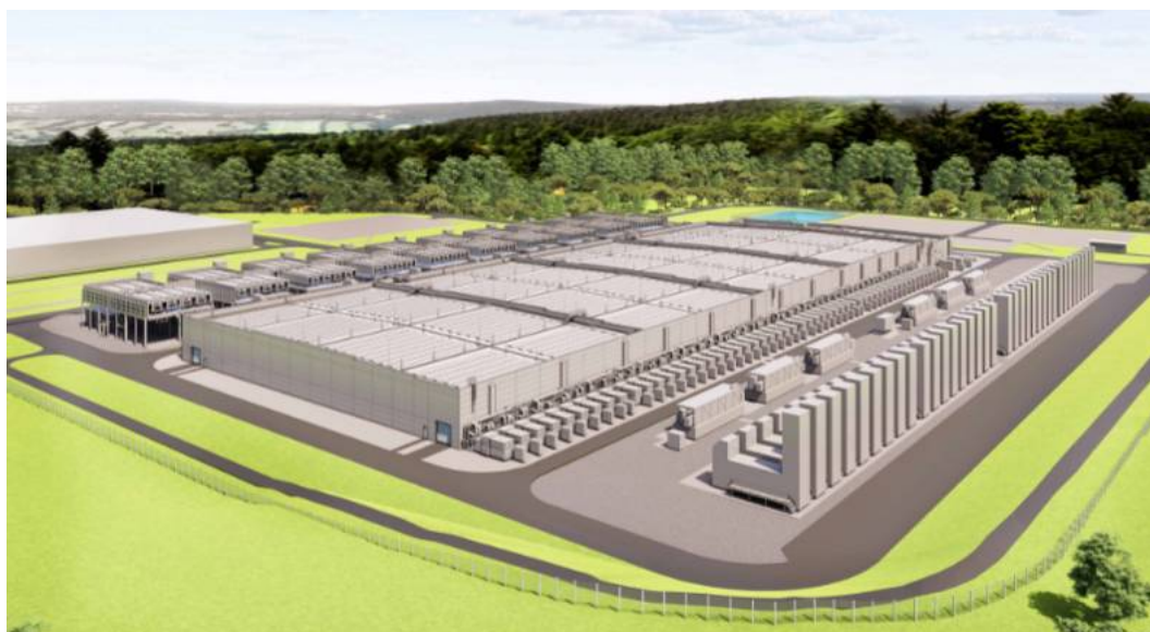
Figur 4. Illustrasjon. Selve datasenterbygningen ligger i midten, mens henholdsvis mekanisk og elektrisk område ligger på hver sin side av bygget.
