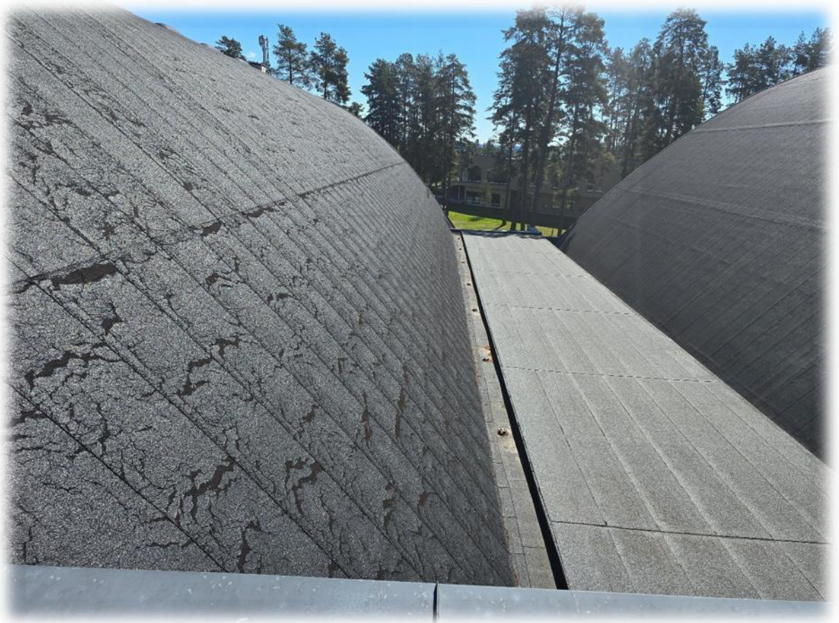
Takpapp på flerbrukshall
