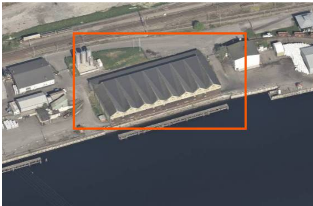
Foto 1: Oversiktsbilde, skråfoto. Lagerhall omsøkt revet, markert med rød firkant.
