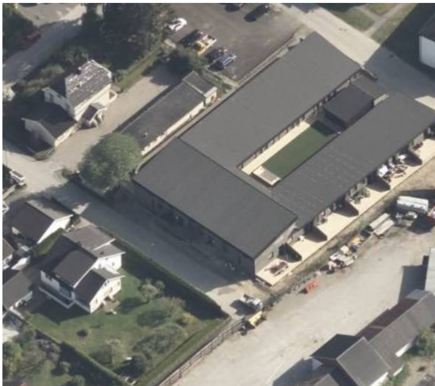
Figur 4. Skråfoto fra 2024 tatt fra nord. Klagernes eiendom ligger nederst til venstre på bildet.
