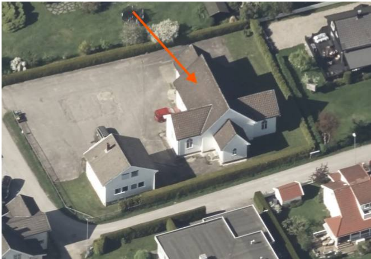
Overflyvningsfoto 1: Bilde av bygning som søkes utvidet
