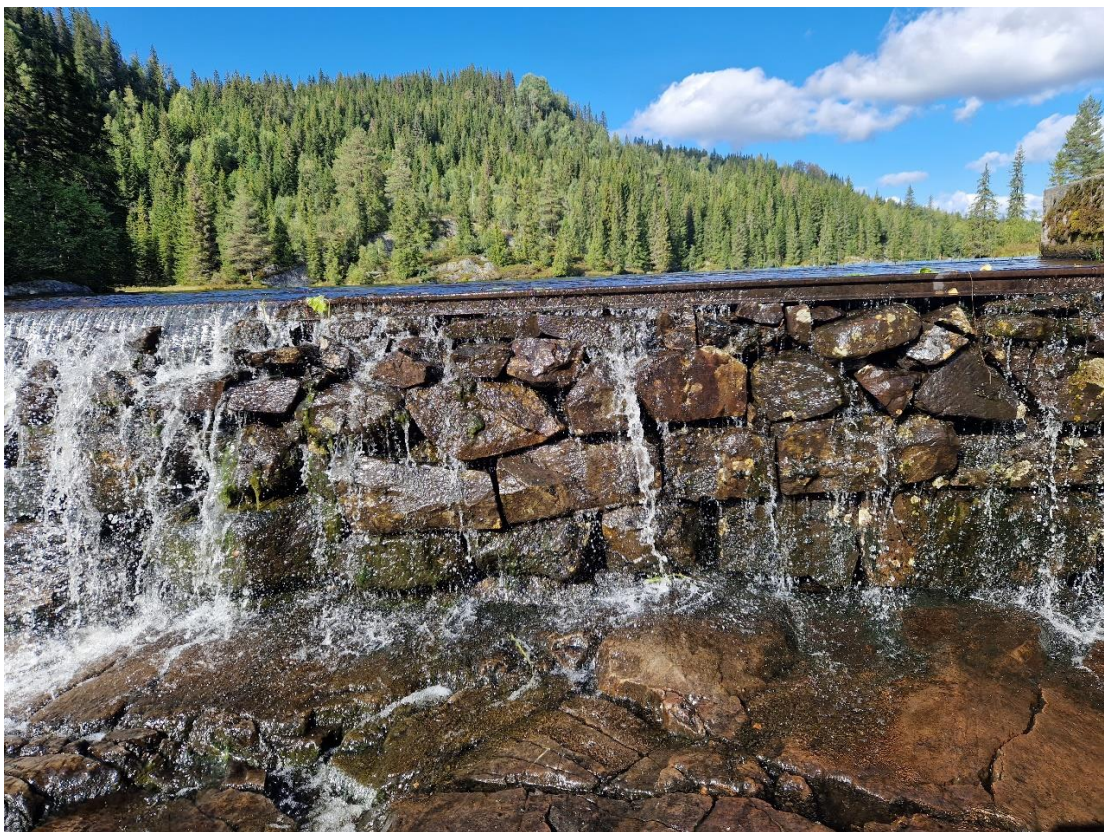
Figur 6 Damveggen ved overløpet
