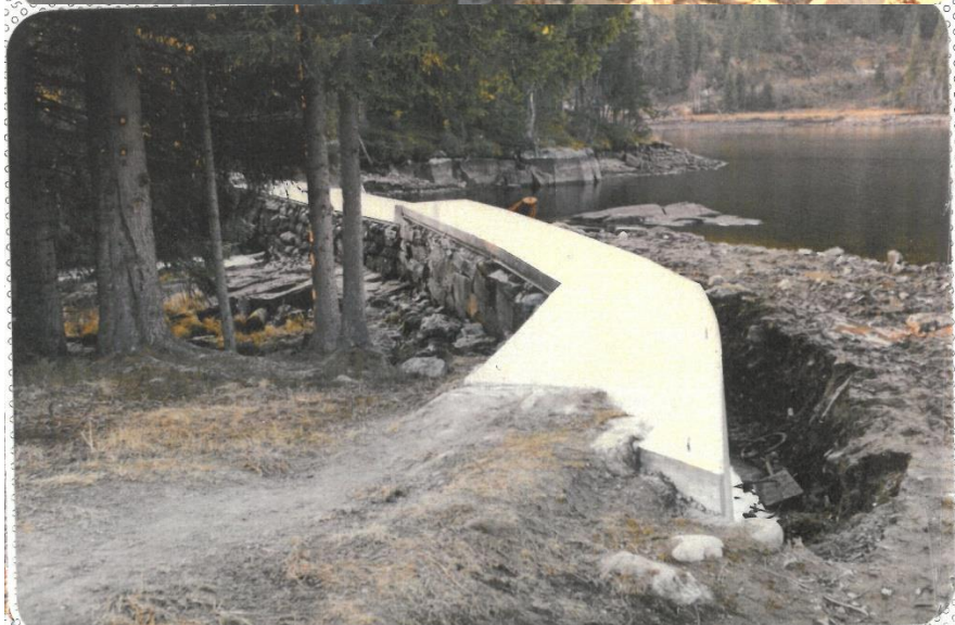
Bilete av dammen før og etter at det vart støypt på ei kappe av betong på vassida og oversida.
