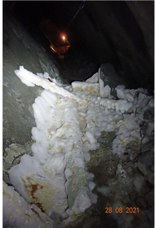
Foto J: Samme sted som vist i Foto I. Sopp har utviklet seg på det råtne trematerialet (props) i de 7 årene siden Mineralforvaltningen hadde befaring i 2014.
