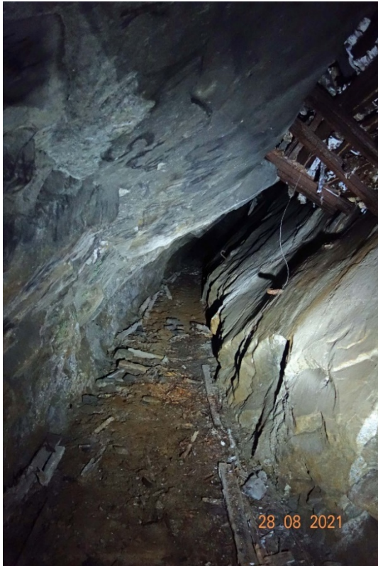
Foto K: Bildet viser at den gamle transportveien langs den smale strossen i Howard malmgang er utvidet ved at det er sprengt ut en hylle i liggen.
