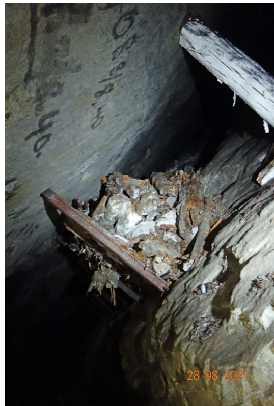
Foto L: Mange steder i strossene hviler utsprengte gruvemasser på stempler av jernbaneskiner over transport-/gangveien. Arbeidet ble utført i aug. 1940, slik det framgår på foto M.
