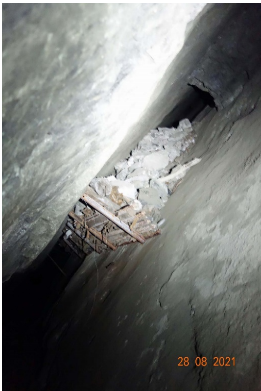
Foto L: Mange steder i strossene hviler utsprengte gruvemasser på stempler av jernbaneskiner over transport-/gangveien. Arbeidet ble utført i aug. 1940, slik det framgår på foto M.
