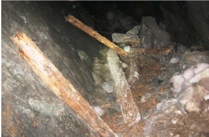
Foto I: Nedfalte tømmerstempler i Johannes gang. (Bilde 11 i Mineralforvaltningens rapport fra 2014).
