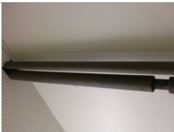
Bilde 64: Cellegummi isolasjon på vannrør.
