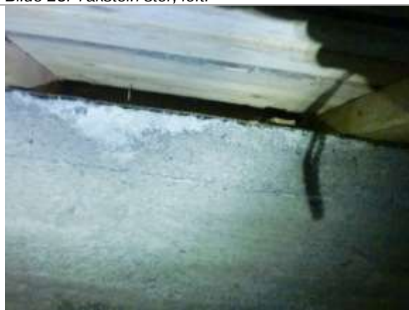
Bilde 27: Betong, krypekjeller fundament.
