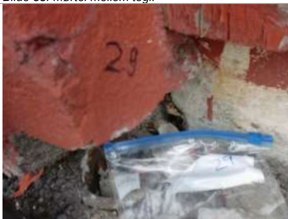
Bilde 40: Murpuss på utvendig pillar/vegg.
