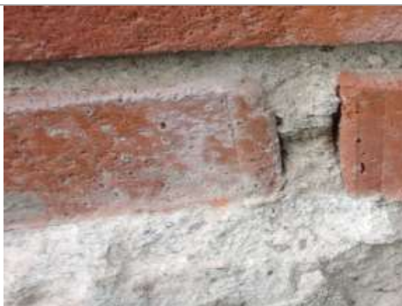
Bilde 38: Mørtel mellom tegl.
