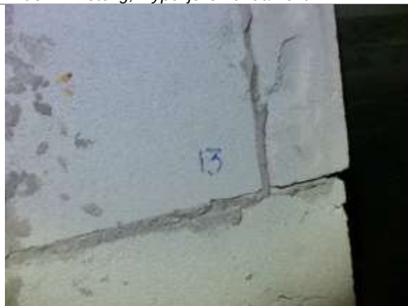
Bilde 29: Mørtel mellom siporex vegg.
