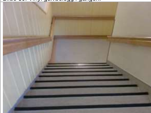
Bilde 61: Vinyl gulvbelegg i trappa.
