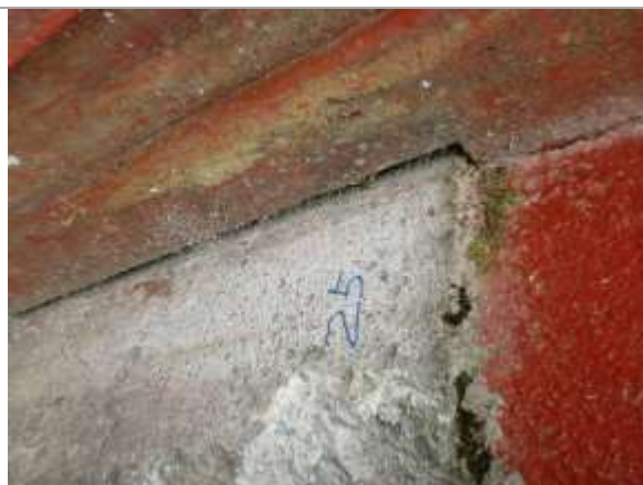
Bilde 37: Betong fra utvendig fundament.
