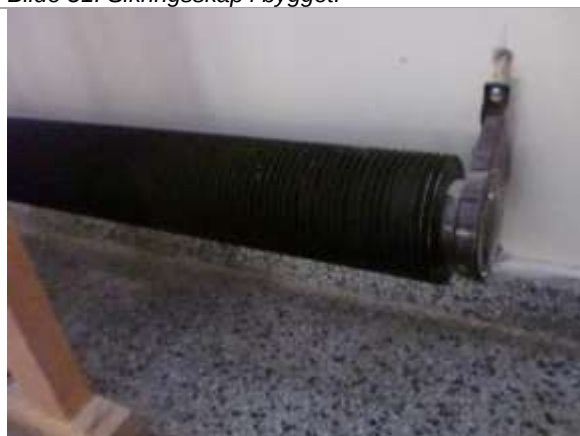
Bilde 83: Varmekilde i bygget.
