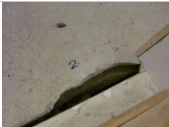
Bilde 21: Betong på gulv, loft.
