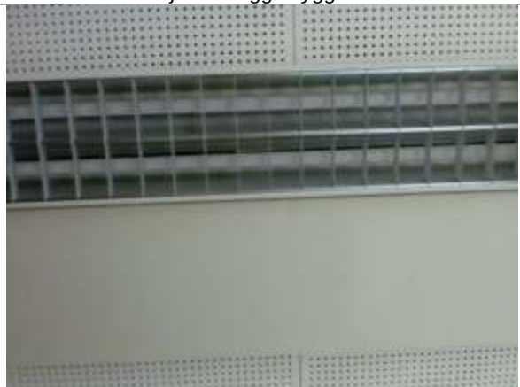
Bilde 78: Lysarmaturer og lysstoffrør i bygget.
