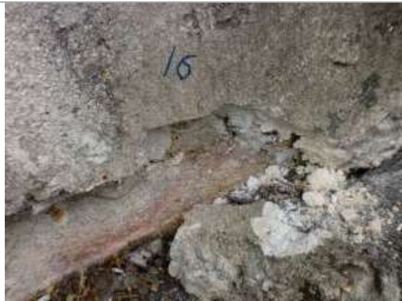
Bilde 32: Betong fra grunnmur, utvendig.
