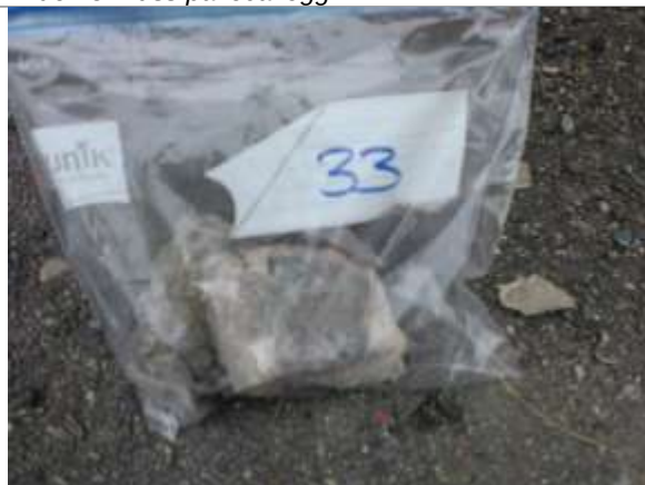
Bilde 47: Betong på grunnmur.
