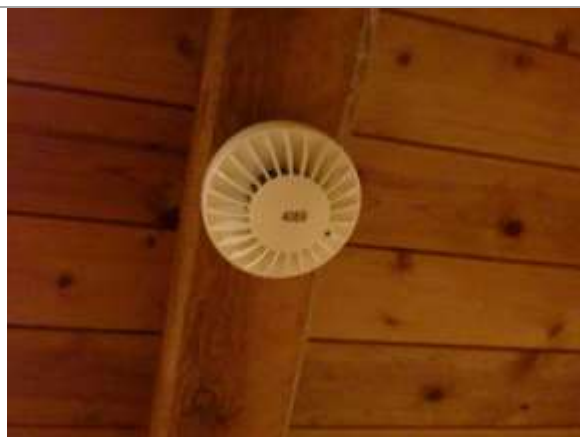
Bilde 79: Røykdetektor i bygget.
