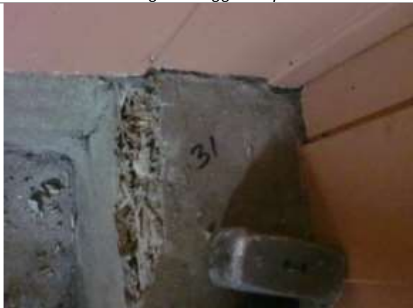
Bilde 16: Puss utvendig på tresnitt.
