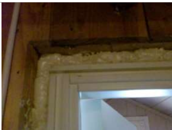
Bilde 72: PUR-skum/fugeskum rundt dør.
