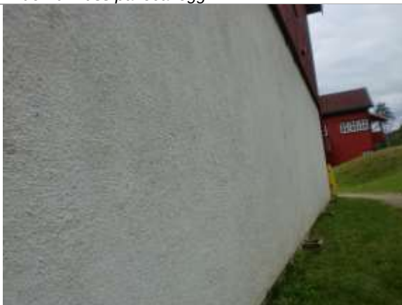
Bilde 48: Betong på grunnmur.
