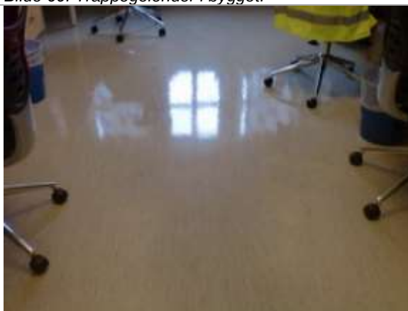
Bilde 62: Vinyl gulvbelegg i kontorrom.
