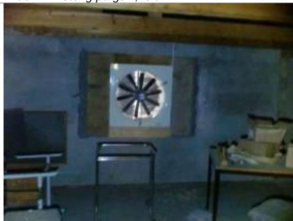
Bilde 23: Puss på vegg, loft.
