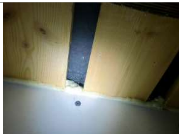
Bilde 69: Tjærepapp bak himlingspanel.
