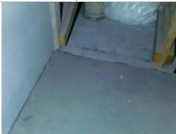
Bilde 24: Betong på gulv, loft.
