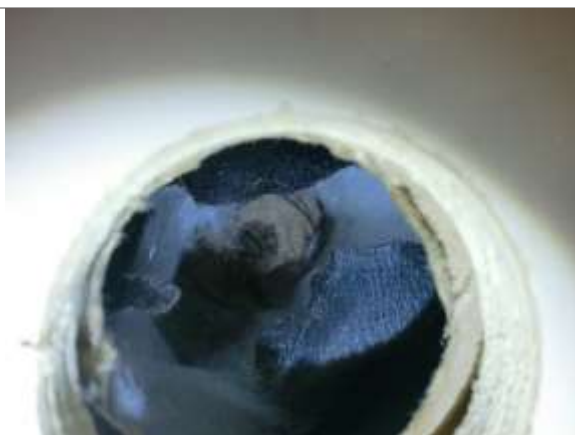
Bilde 70: Tjærepapp mellom innvendigvegg.
