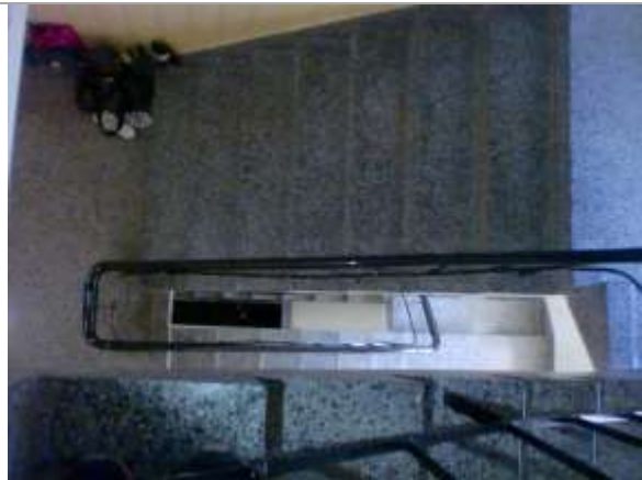
Bilde 26: Terrazzo på trapp.
