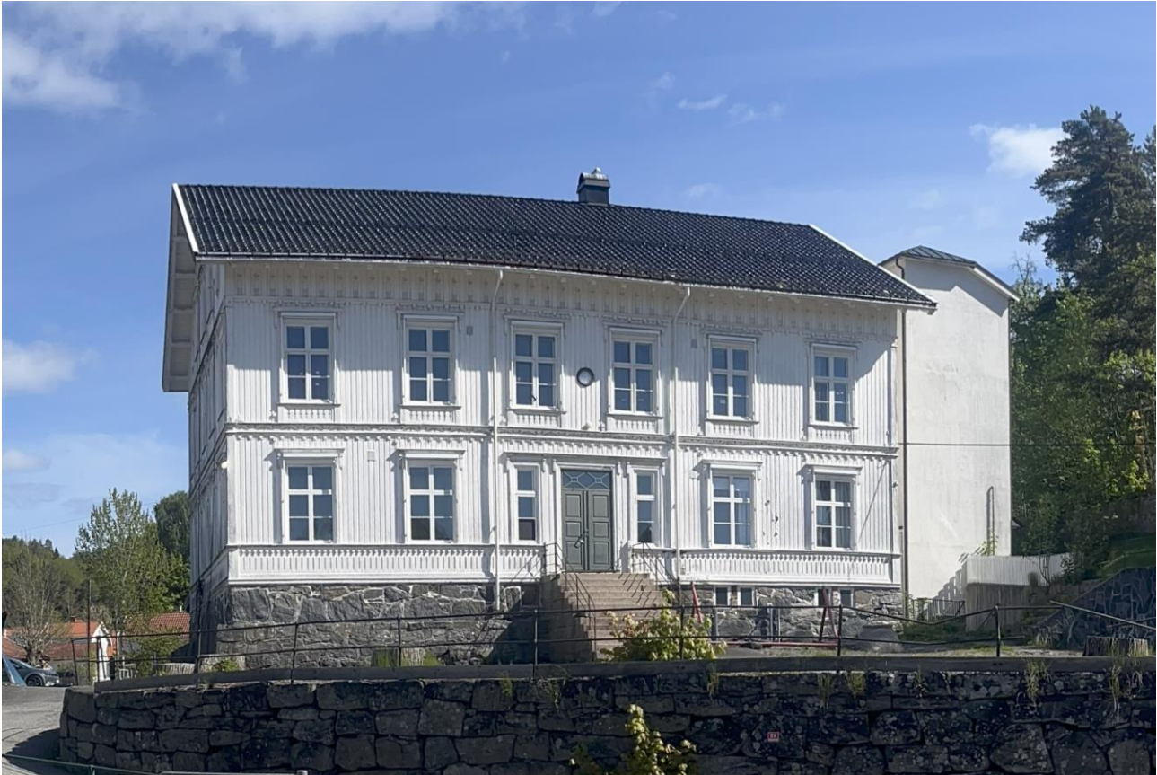
Figur 1: Det gamle skolebygget, Arne Garborgs vei 11. Kilde: Multiconsult.
