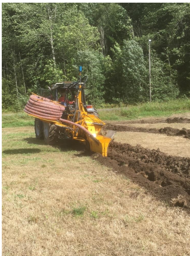
Kjedegraver til dreneringsarbeid – foto: Morten Foss
