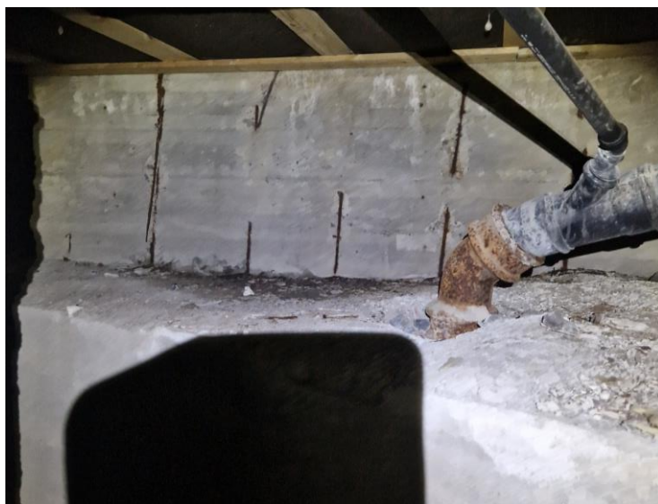
Krypkjeller. Her tettet med asfalt vindtett mot gulvbjelkelaget over.
