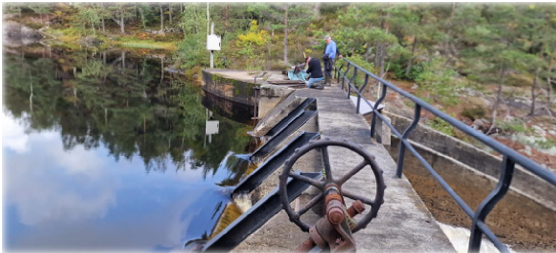
Den gamle fløtningsdammen ved Savann hvor det planlegges et nytt inntak.
