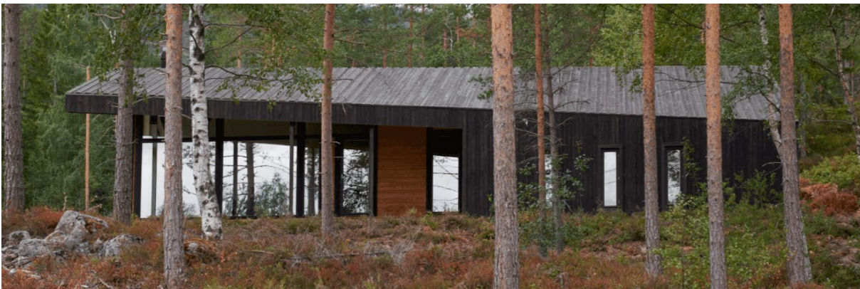
Figur 27. Eksempel på hytte med tretak, bygd mellom trærne uten store terrenginngrep. Foto: Rindalshytter.
