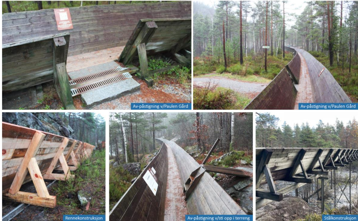
Figur 2 Bilde fra eksisterende situasjon i Steinsfoss Tømmerrenne, som viser konstruksjonen og utformingen av tømmerrenna.
