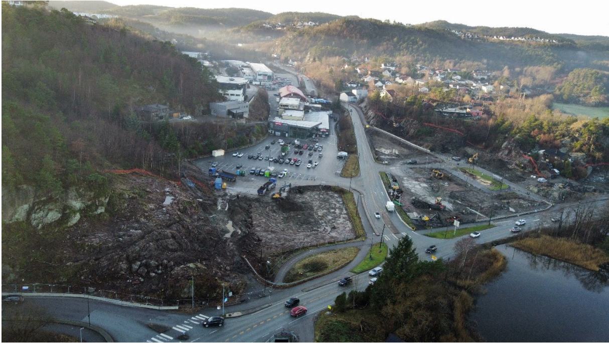
FIGUR 5 ARBEID MED KJOSKRYSET BLE IGANGSATT I 2025. DRONEFOTO: MAGNUS MIKALSEN
