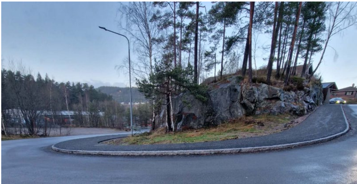
FIGUR 11 NYTT FORTAU LANGS MYRVEGEN VED SKARPENGLAND SKOLE. FOTO: VENNESLA KOMMUNE
