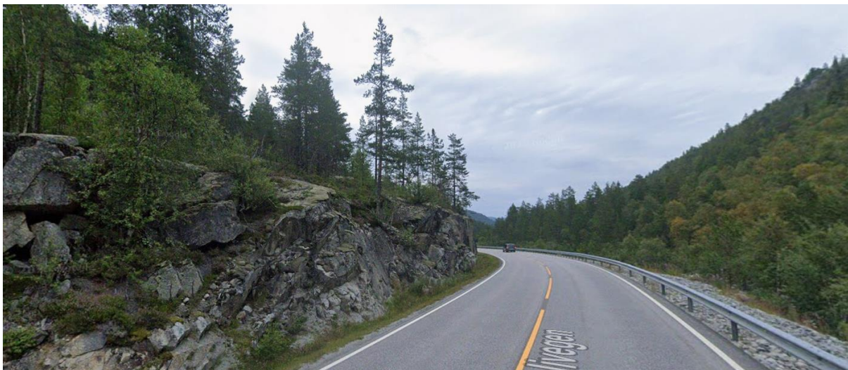
Figur 15. Dagens veg ved ca. profil 3700 har fjell i dagen tett på vegen. Kurveutbetring medfører noko høgare fjellskjering, men til fordel for betre sikt og trafikkssikkerheit (Google Maps).
