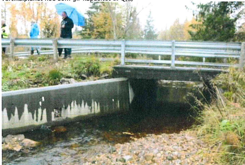
Figur 5: Kulvert under FV362, oppstrøms (foto: John Oddvar Selland)
