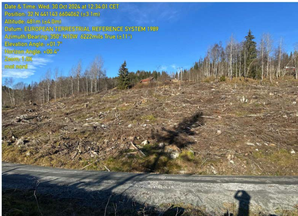
Figur 7 Bilde fra lokalvegens sving mot nord viser øvre fyllingsområde med bygninger på toppen
