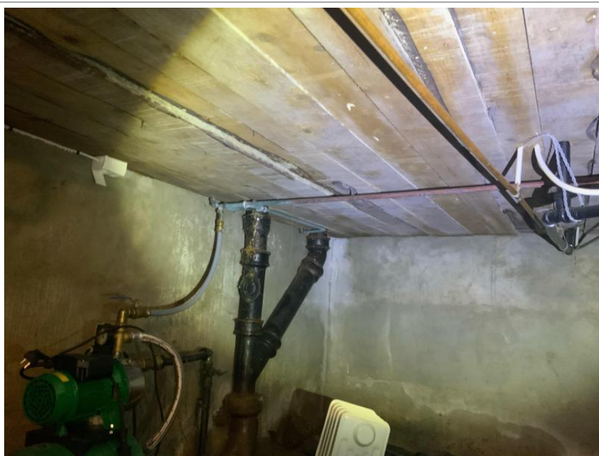
Bordhimling/stubbloft i krypekjeller.
