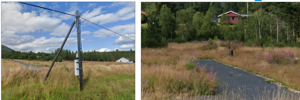
Figur 17. Høgspenn 22 Kv er lagt i jordkabel og det er tilrettelagt for straumforsyning i feltet.
