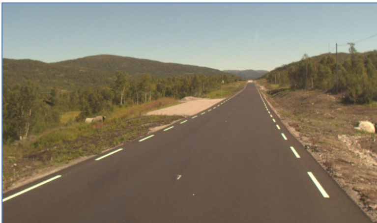
Aug.24, anlegget er ferdigstilt
