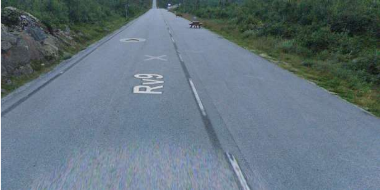
Figur 8 Utvidet bredde på deler av veistrekningen, med eksisterende rastemuligheter til høyre, der det også er tilrettelagt for resting og spising i form av krakker.
