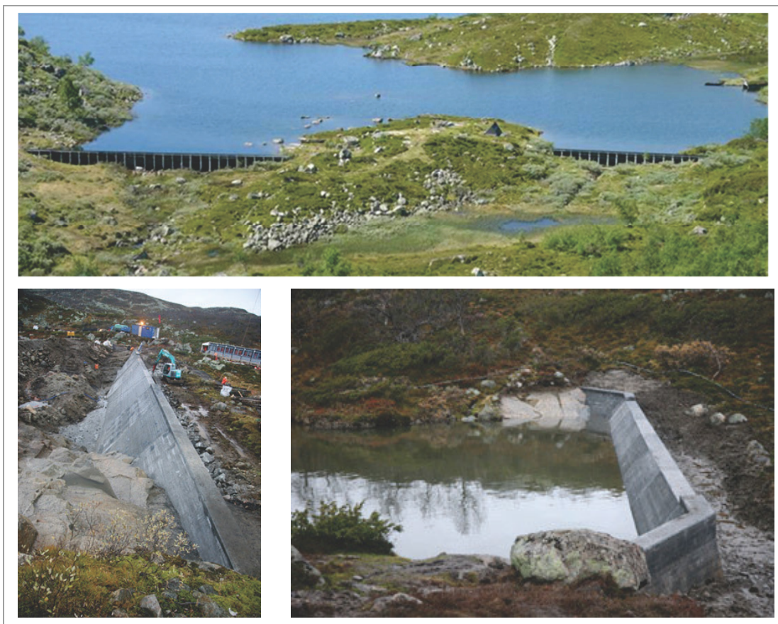
Figur 4 Damanlegget ved Gurivatn (de gamle trebukkedommene og de nye betongdammene).
