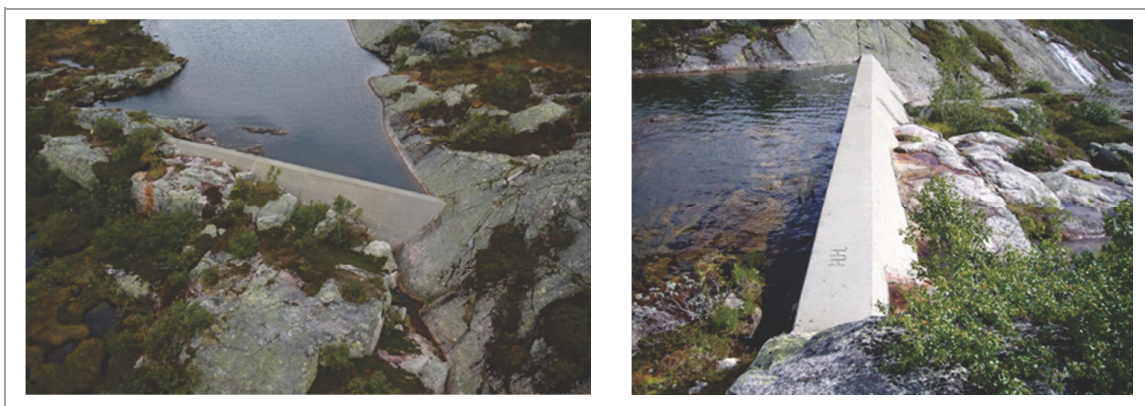
Figur 8 Damanlegget ved Øvre Vrongevatn.
