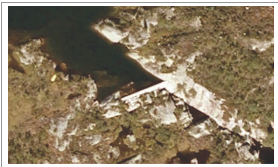
Figur 7 Flyfoto av Dam Øvre Vrongevatn.
