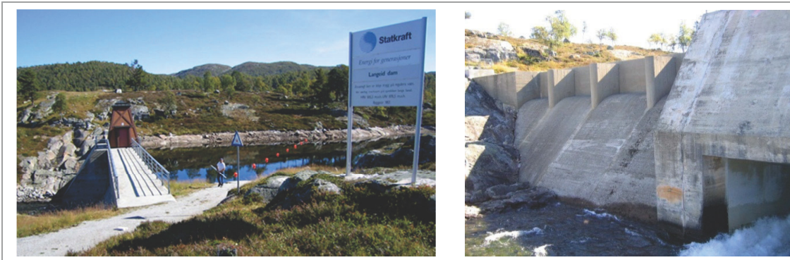
Figur 12 Damanlegget ved Langeidvatn.
