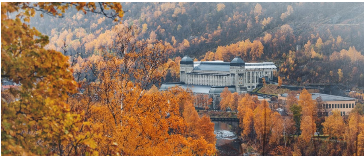
Hydros vannkraftverk Såheim på Rjukan. (Foto: Hans Fredrik Asbjørnsen / Hydro)
