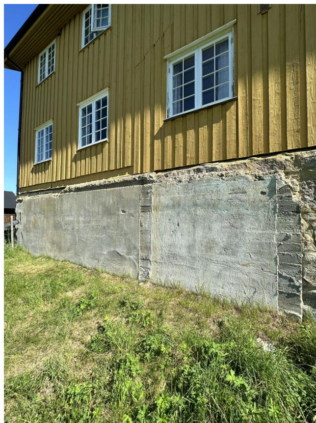
Her har det vært et tilbygg, det kan se t som det er forskalt og støpt på utsiden
