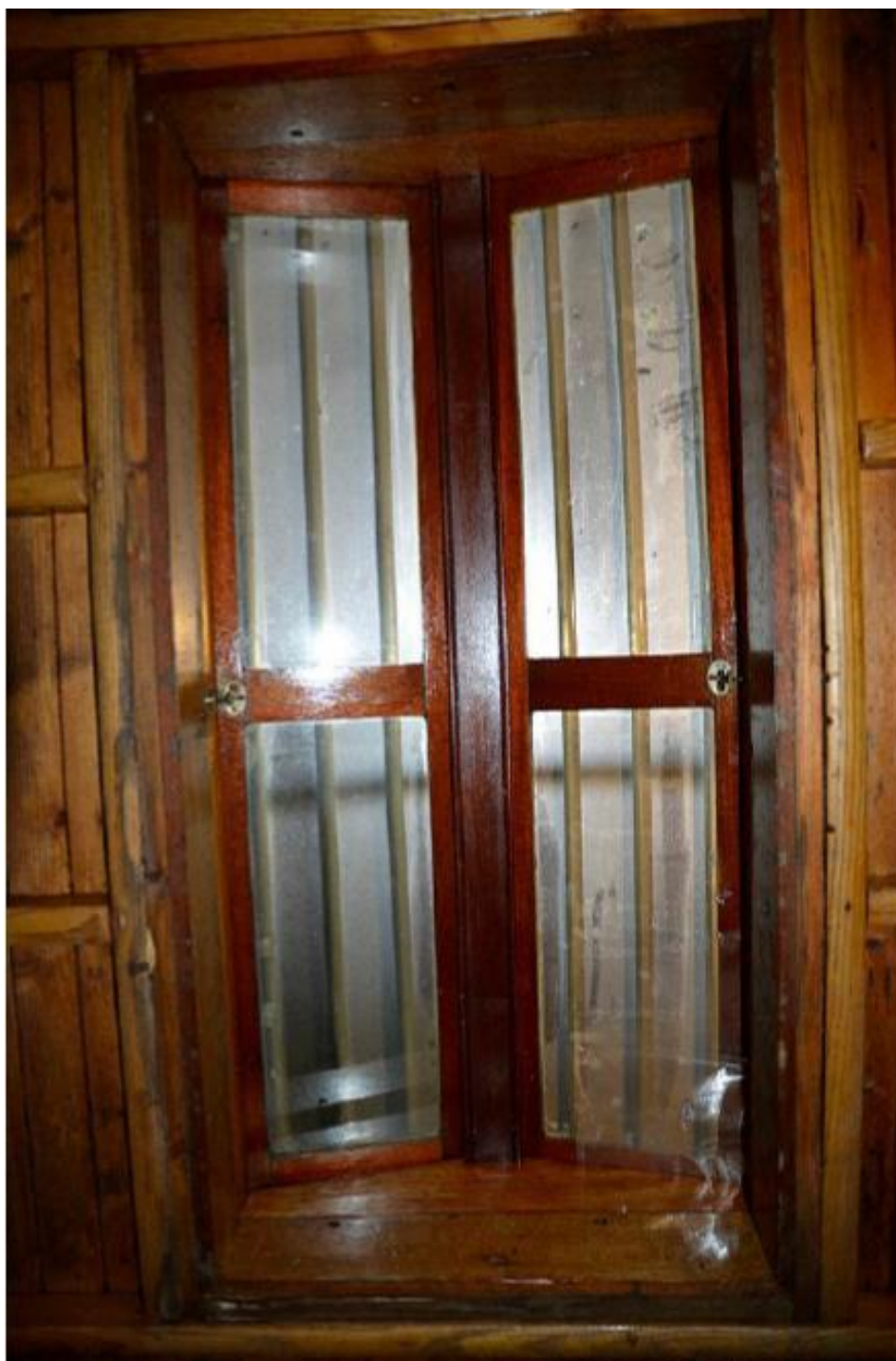
Bilde 30 Skylight sett fra salongen
