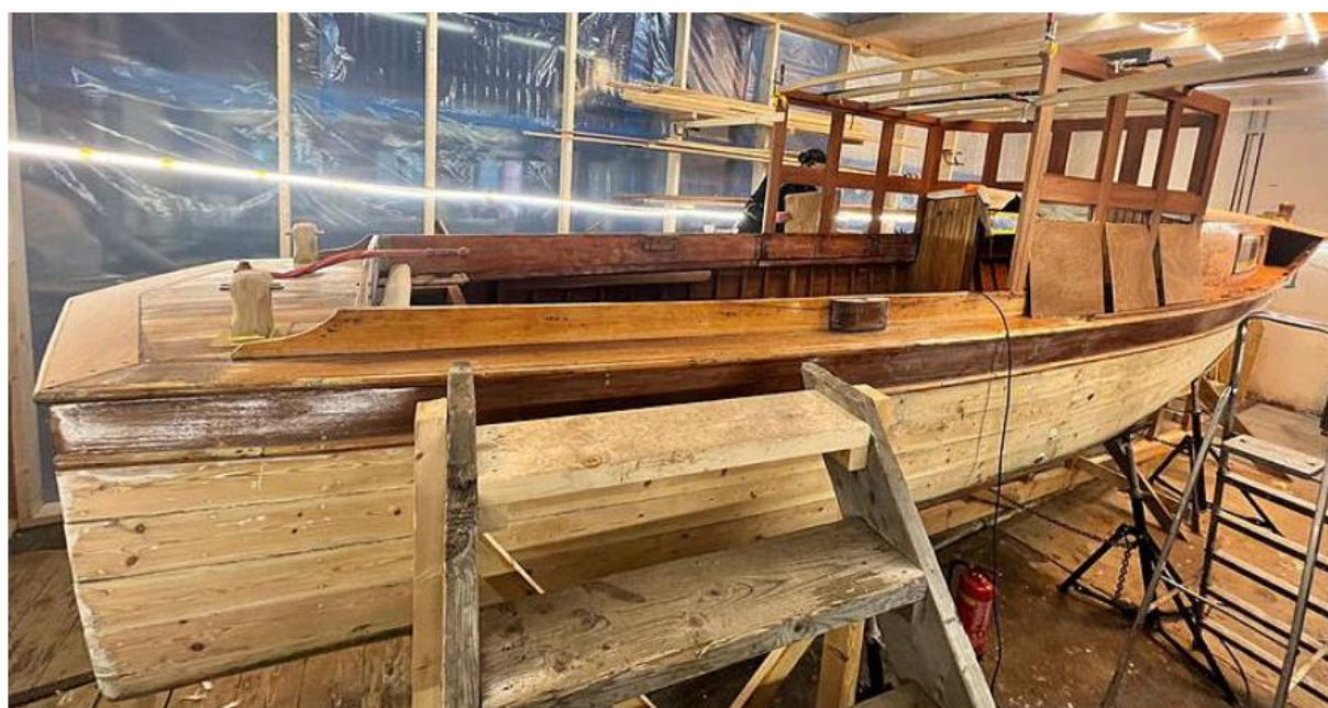
Bilde 38 Viser arbeider med oppbygging av styrhus
