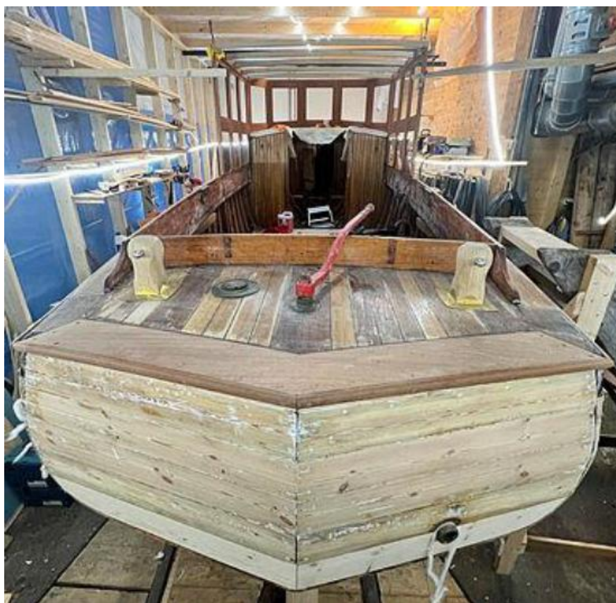
Bilde 37 Her er konstruksjonen bjelker på plass
