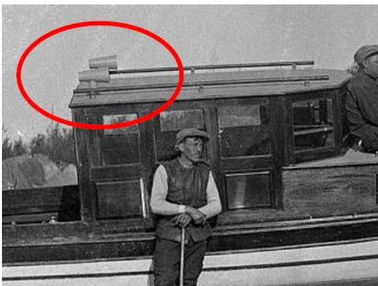
Bilde 8 To stk ventiler på taket
